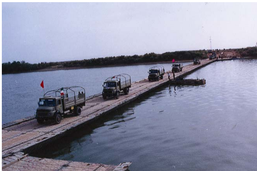
پل شناور نصب شده روی رودخانه کارون در دارخوین در عملیات بیت‌المقدس ۱۳۶۱/۱/۵
