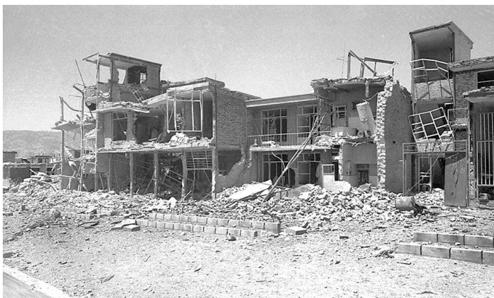
ساختمان‌های تخریب شده توسط منافقین
